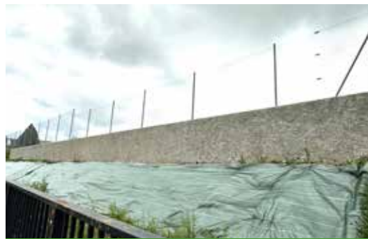
Mur de soutènement au skate-park
