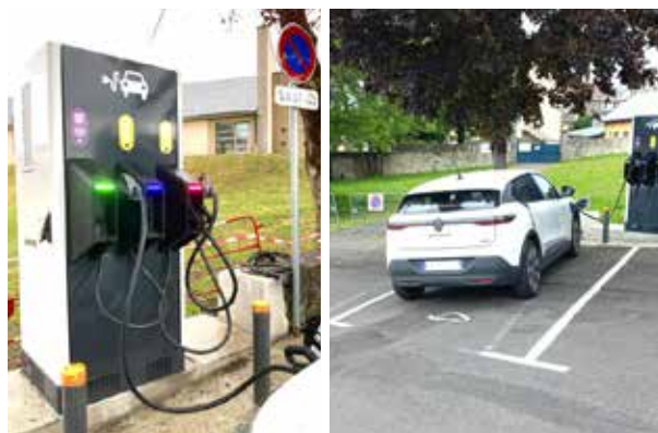
Installation et mise en service d'une borne de recharge pour véhicules électriques parking du 14 juillet (rue du 8 mai)
