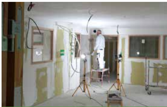
Aménagement des locaux de la future micro-crèche
